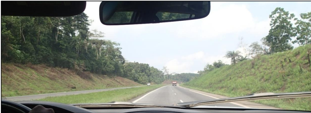
Figure 3.1 : Autoroute – Abidjan à Yamoussoukro
