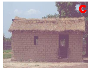
Maisons en géo béton montée avec la terre
